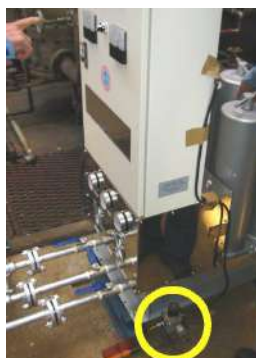
← 計装用空気をパージ 防爆対策のひとつとして、微量の 圧縮空気で盤内を正圧に保ちます。 ↓ 空気流量調整器
