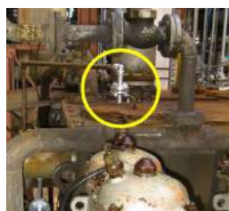
↑ 返油用配管 オイルタンクのフタ にフランジを溶接 ← メッシュフィルター (洗浄再生式)
